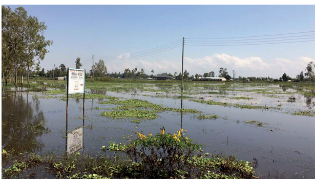
figuur 1 Overstroming op het terrein van de oude locatie van de Ombaka Secondary School
