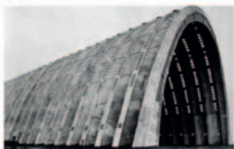
De hangar op de foto is 175 meter lang. De opening in het vooraanzicht van de hangar heeft de vorm van een parabool.
